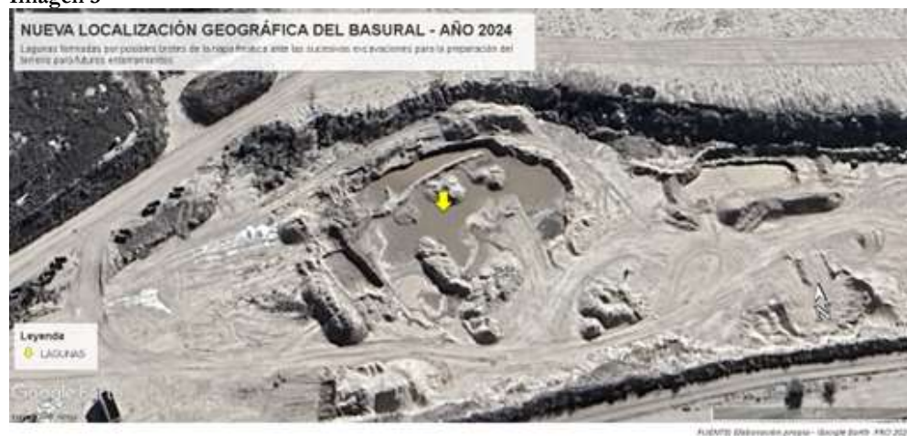
Posibles afloramientos de agua en el nuevo sitio del CDRF
